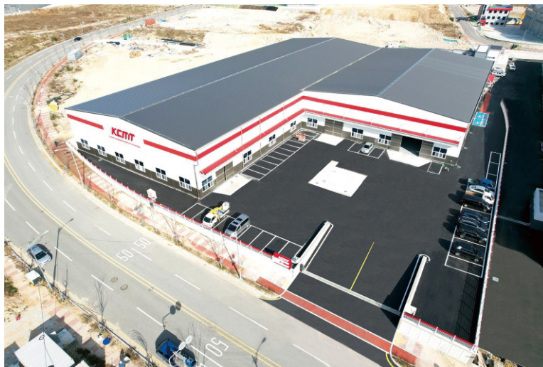
Die zweite KEco Fabrik
