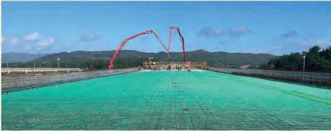
포항-영덕 고속도로 1공구
