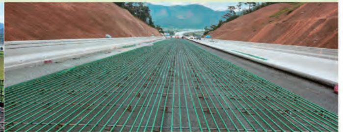
함양-창녕 고속도로 5공구
