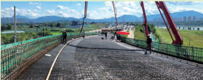
안성-구리 고속도로 14공구 교량 Slab
